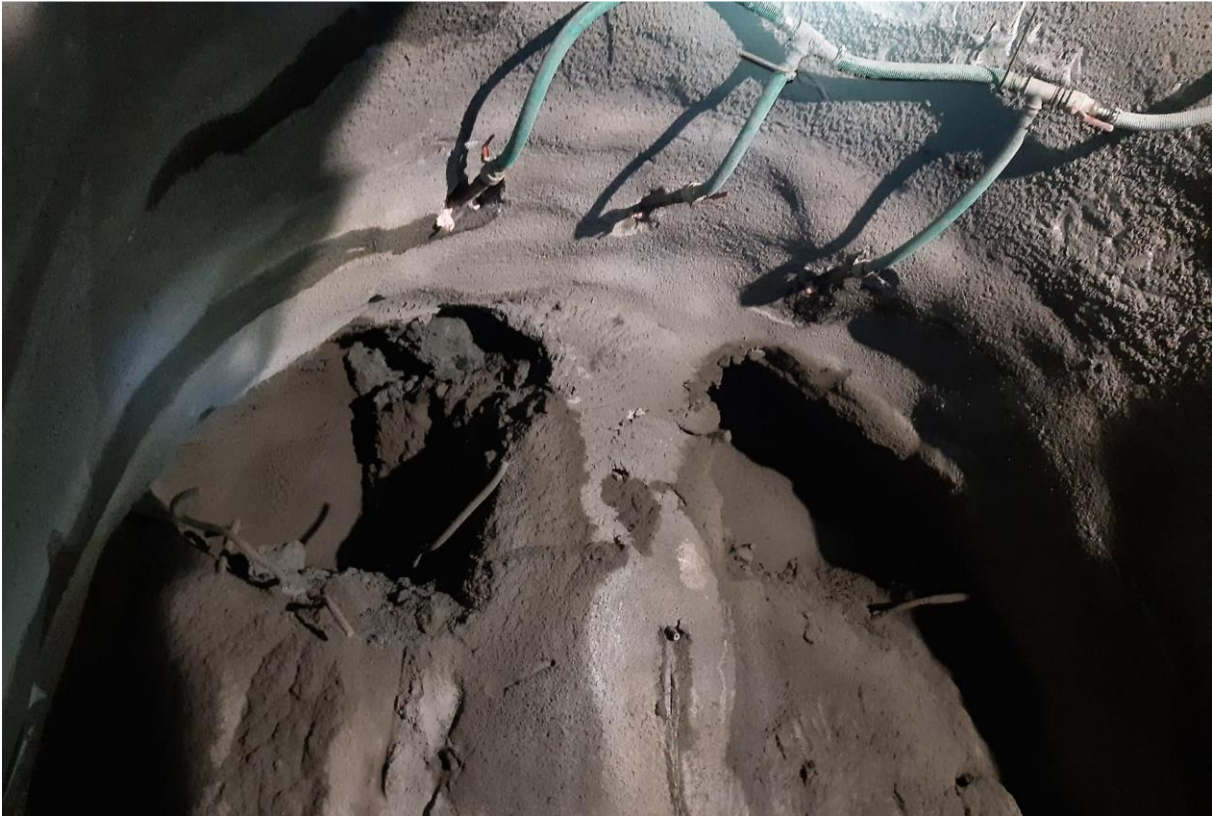
Figur 21: Vakuumlanser og seksjonsvis uttak av løsmasser i gangtunnel
