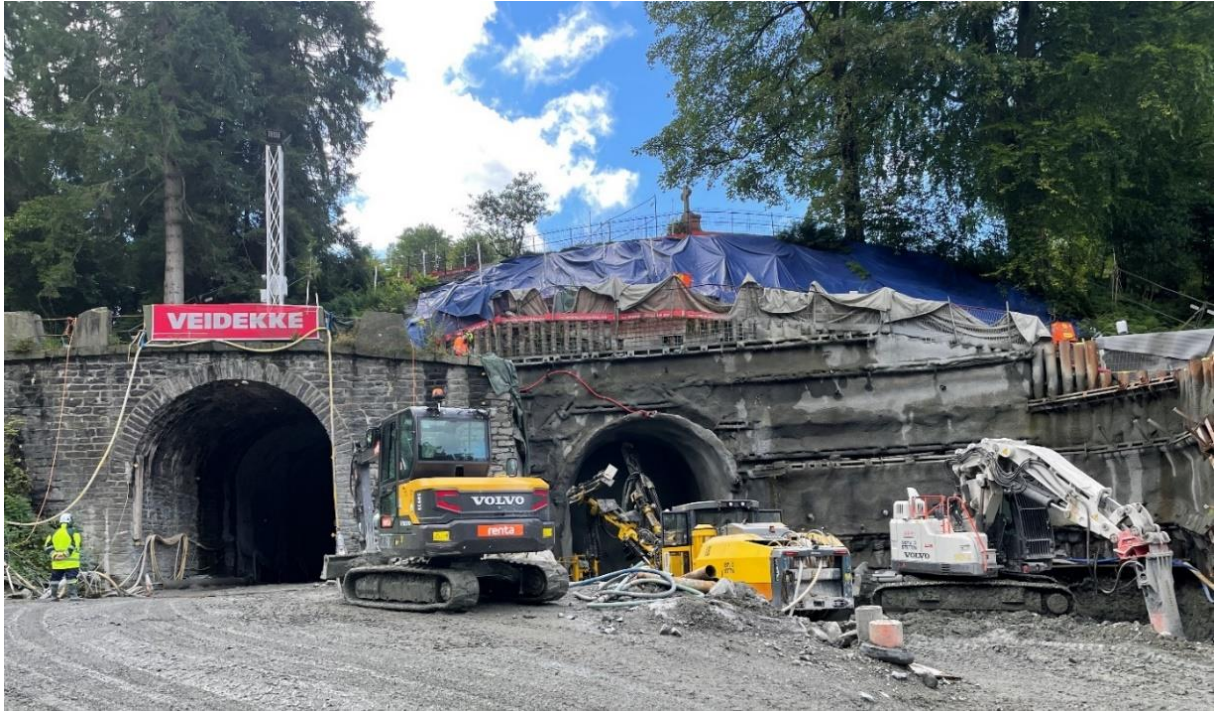
Figur 5: Sykkeltunnel til venstre i bildet og gangtunnel etablert i byggegrop til høyre viser den begrensede plassen
