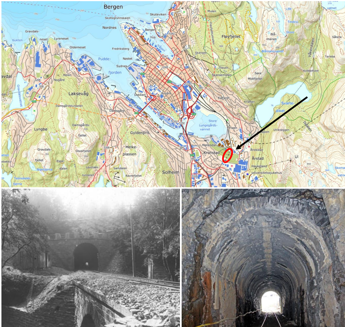
Figur 1: (1) Prosjektplassering merket med rød ring, (2) Bildet fra 1913 og (3) Tunnel i løsmasser før oppstart av prosjektet
