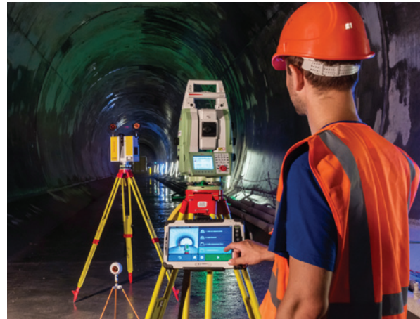
Amberg Navigator: Mit einem Tablet ein ganzes Tunnelprojekt steuern und kontrollieren
